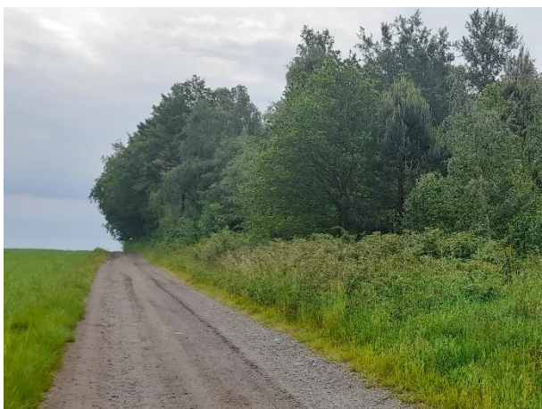
Fot. 22. Droga śródpolna – obręb Rudzica
