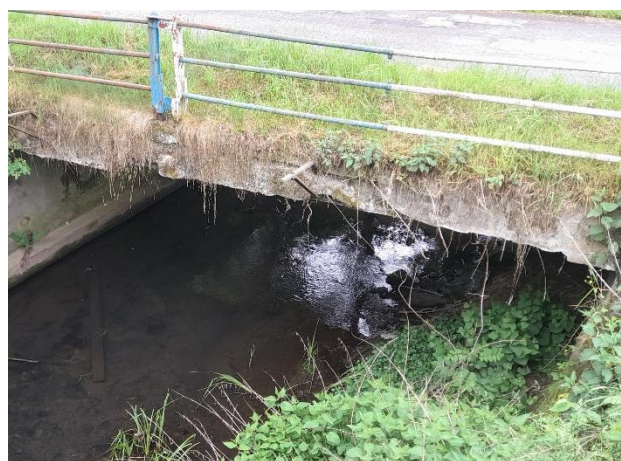
Fot. 12. Most na cieku Siekierka – obręb Zaręba
