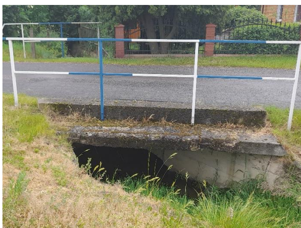
Fot. 11. Most na cieku Lipniak – obręb Rudzica
