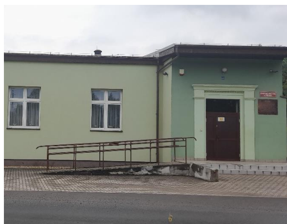
Fot. 29. Świetlica wiejska – obręb Rudzica
