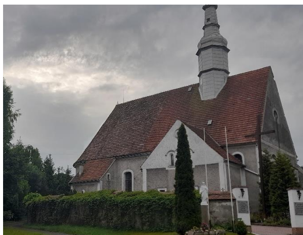
Fot. 65. Zabytkowy kościół wymagający renowacji – obręb Rudzica
